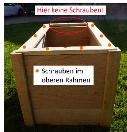
5. Zum Abschluss: Dreht die Kiste nochmals um und **schraubt den unteren Rahmen an den kurzen Seitenteilen fest**, legt den Boden ein. Den Boden könnt ihr nach Belieben festschrauben und/oder Löcher als Wasserablauf bohren.
