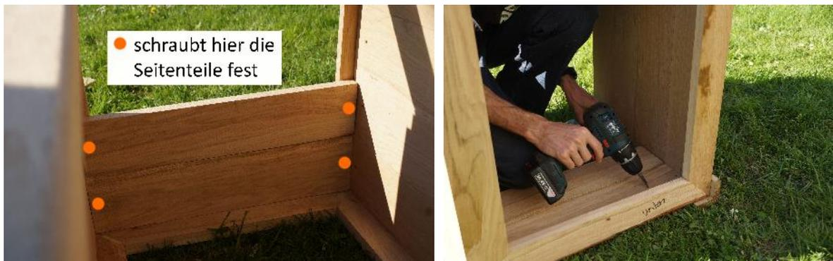
4. Montiert jetzt den oberen Rahmen mit drei bis vier Schrauben an den Längsseiten und ein bis zwei Schrauben an der kurzen, rechten Seite.
