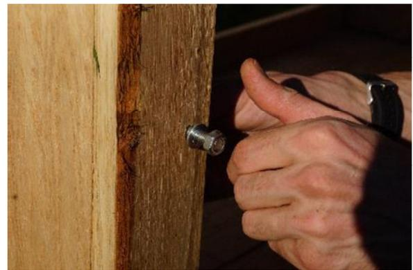
**Wichtiger Hinweis:** Damit die Mutter richtig festgeschraubt ist, schraubt **gleichzeitig an beiden Muttern**. Ziel ist, dass die FixPlus-Stange stabil von beiden Seiten Halt bekommt und senkrecht steht.
