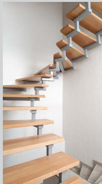
Ein halb gewendelte aufgesattelte Treppe
