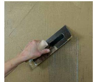
Trockenbauplatte aus Lehm und Hanf zum Bepanken von Holz- und Metallständerkonstruktionen von Innenwänden, Vorsatzschalen, Decken- und Dachflächen. Die Claytec Greentech 700 ist fest und stabil, scharfkantig und maßgenau. Sie hat beste baubiologische Eigenschaften. Das Trockenbau-Unterkonstruktionsraster ist 62,5 cm. Ihre Wasserbeständigkeit erlaubt auch dicke Lehmputzaufträge.
