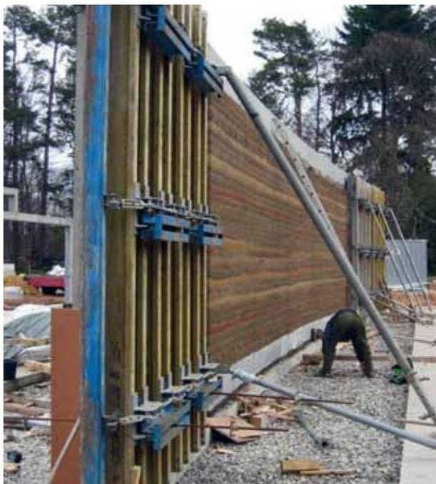
Abbildung 1.1.2: Montage eines vorgefertigten Stampflehmelements auf der Baustelle.
