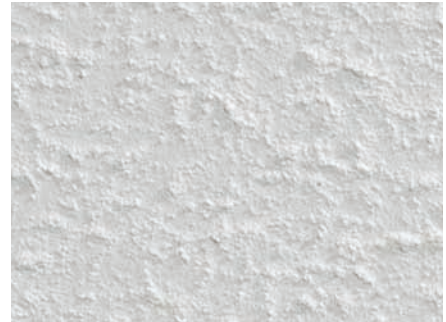
Struktur einer gut vorbereiteten Gipskartonplattenfläche
