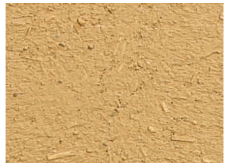
Struktur einer gut vorbereiteten Fläche aus Lehm-Unterputz
