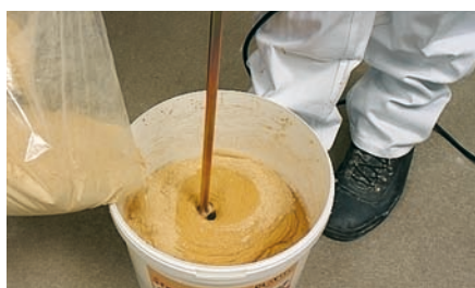
Einrühren des Eimerinhalts in Wasser 30 Min. quellen lassen
