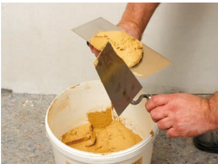
Entnehmen des Mörtels
