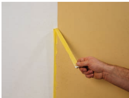
Abziehen nach dem Abwischen
