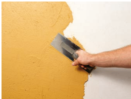
Aufziehen mit dem Glätter
