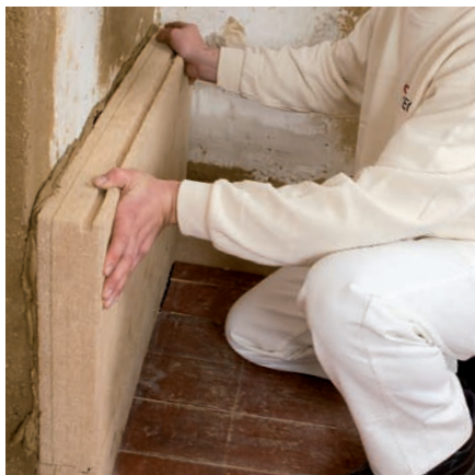
Kontaktschluss durch Eindrücken in den plastischen Mörtel
