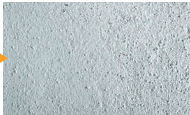
Grundbeschichtung/Rissverschlämmung mit KEIM Contact-Plus-Grob
