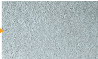
Grundbeschichtung/Überbrückung der Altbeschichtung mit KEIM Contact-Plus
