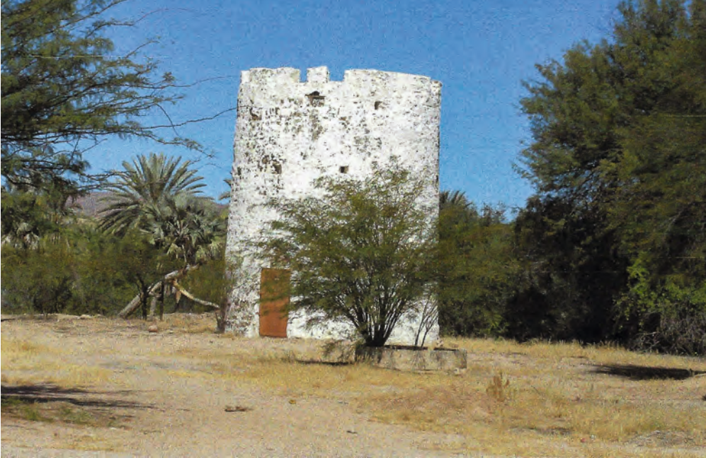
Abb. A.3 - 114: Pulverturm von Nordwesten im August 2017
