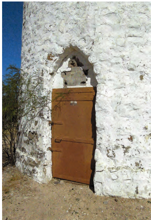
Abb. A.3 - 115: Pulverturm von Nordwesten im August 2017
