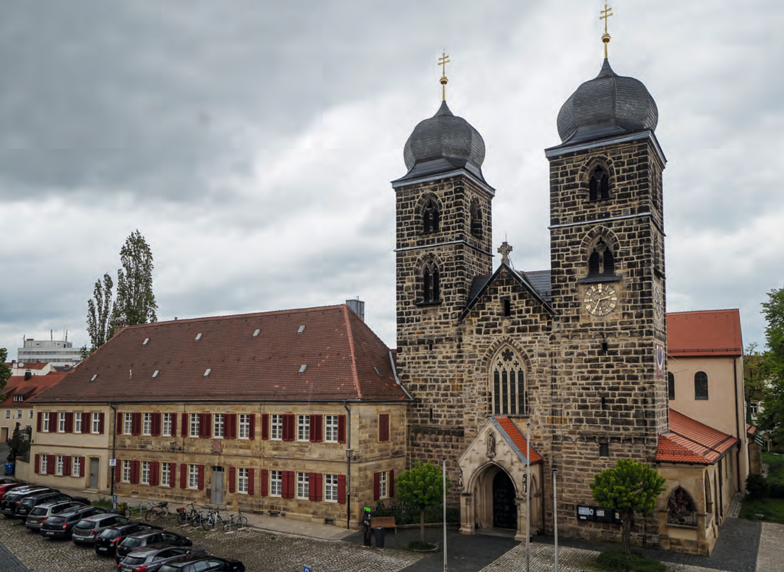
Abb. 1: Bamberg, St. Gangolf, Blick auf Kirchner- und Kapitelhaus (heute Pfarrhaus) sowie die Kirche von Westen (Foto: B. Marr, 2021).
