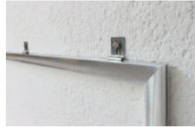
Richtige Position der Schrauben und Langlöcher in den Hakenblechen bei der Verschraubung.
