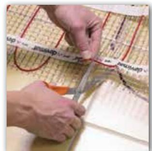
**2** Schlitz für Fühlerleerrohr einfräsen, Leerrohr verlegen und Fühlerhülse am Ende aufstecken. Der Fühler muss mittig zwischen den Heizleitungen verlegt werden.
