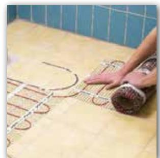
**3** Fußboden gründlich reinigen und trocknen. Je nach Untergrund Haftgrundierung auftragen, selbstklebende Heizmatte ausrollen und durch Andrücken am Boden fixieren.
