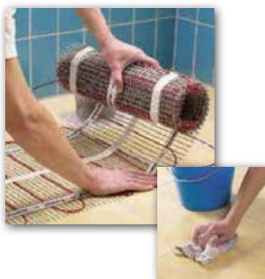
**6** Nach erfolgter Verlegung der Heizmatte kann diese in Estrich oder Flexkleber eingebettet und anschließend mit Fliesen versehen werden.
